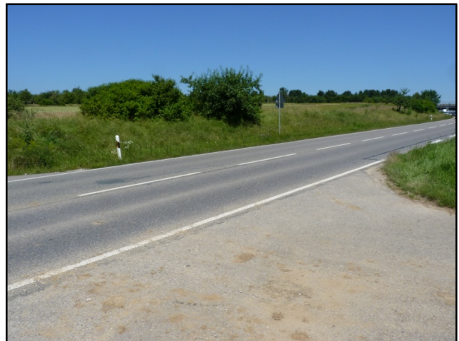
Abb. 3 Straßenböschung an Esslinger Straße (nördlicher Ausbauabschnitt).
